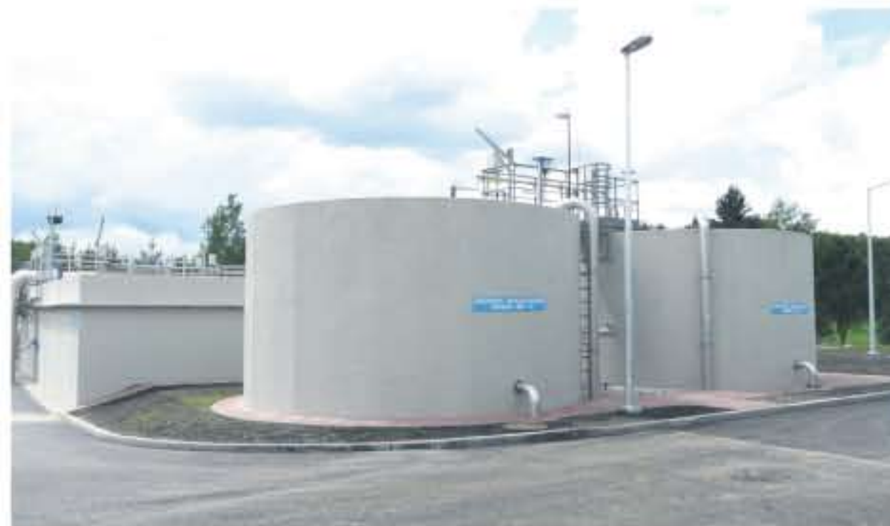
Zbiorniki magazynowe osadu
