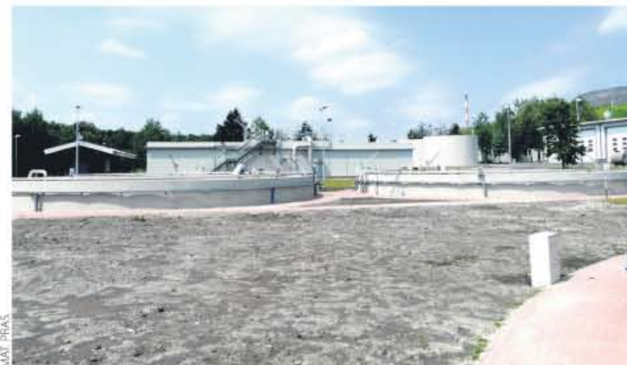
Wydzielone komory stabilizacji tlenowej
