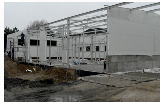
Budynek techniczny - montaż ścian
