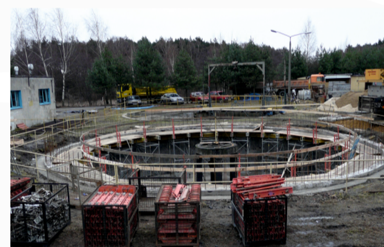
Osadnik wtórny - modernizacja
